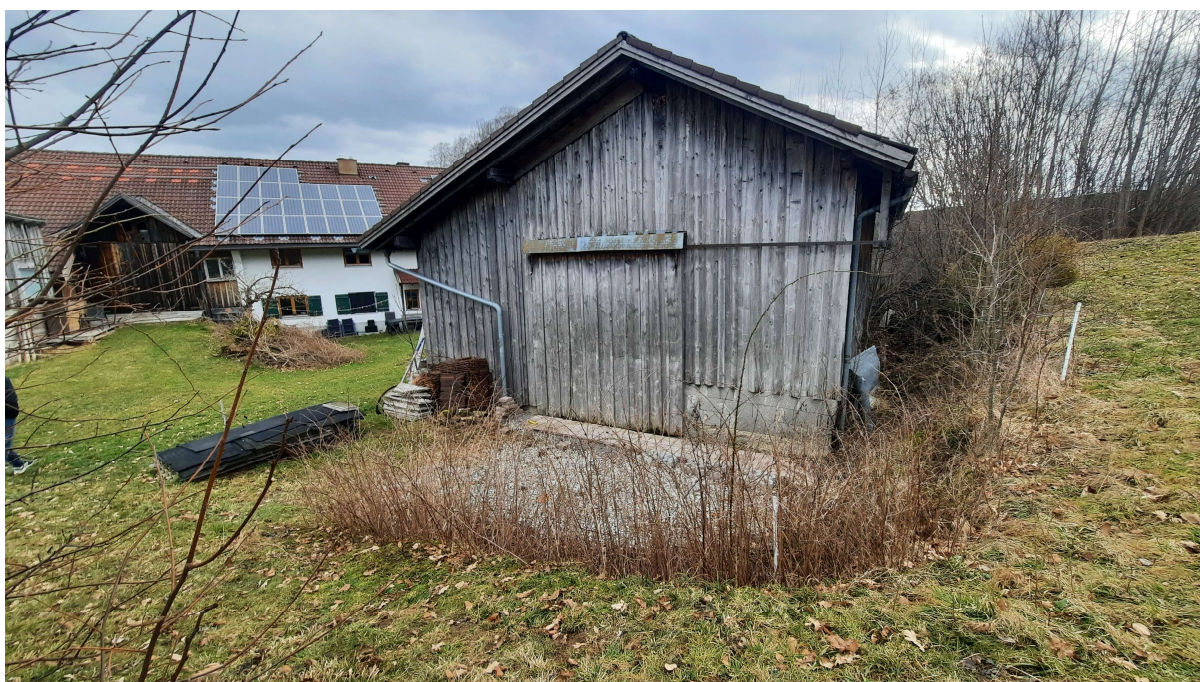
Abb. 7 Blick von Westen Richtung Osten zum bestehenden Stadel (AGL, März 2023)
